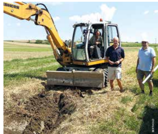
Martinsdorf Aushub Graben Eschenweg-St. Laurentstraße 1
